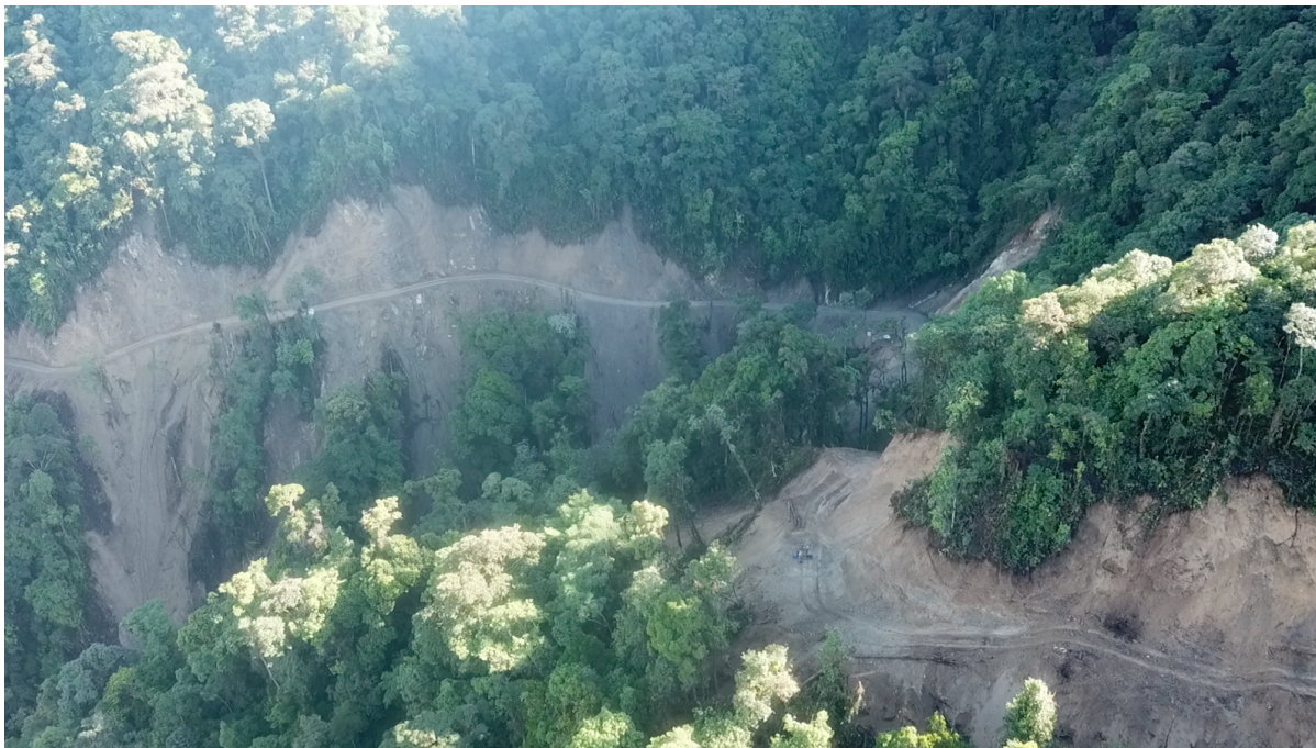
Carretera en construcción con excavadoras en operación el 2 de diciembre 2018 a las 8:25am (lat 0.306682°, long -77.656055°) a aproximadamente 950 metros del río Cofanes.
